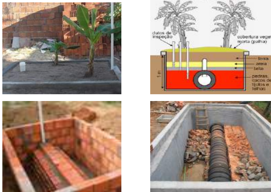
Figura 81– Tanque de evapotranspiração
