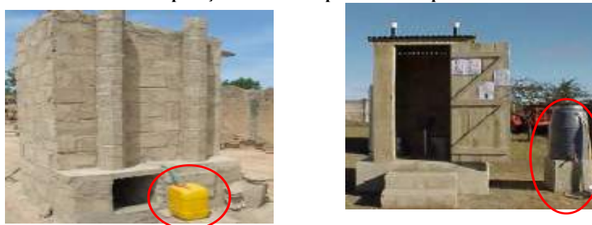
Figura 85 – Bombonas de armazenamento temporário (esquerda) e de estocagem (direita) em sanitário com separação de urina implantadas em países da África
