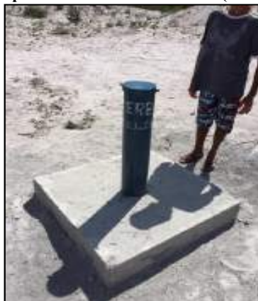
Figura 19 – Poço perfurado em Santo Inácio (ainda sem operação)
