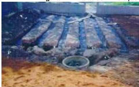
Figura 71 – Valas de infiltração construídas e esquema do leito filtrante
