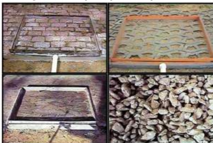
Figura 97 – Exemplos de pavimentos permeáveis
