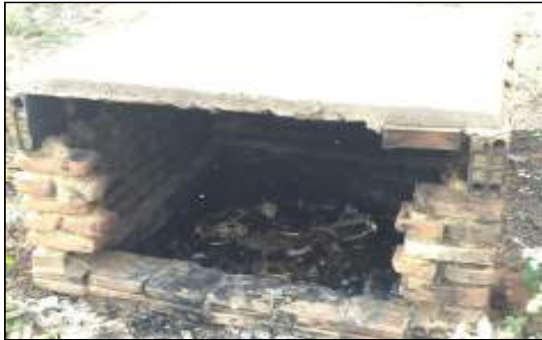
Figura 54 – Incinerador improvisado para queima dos resíduos de saúde
