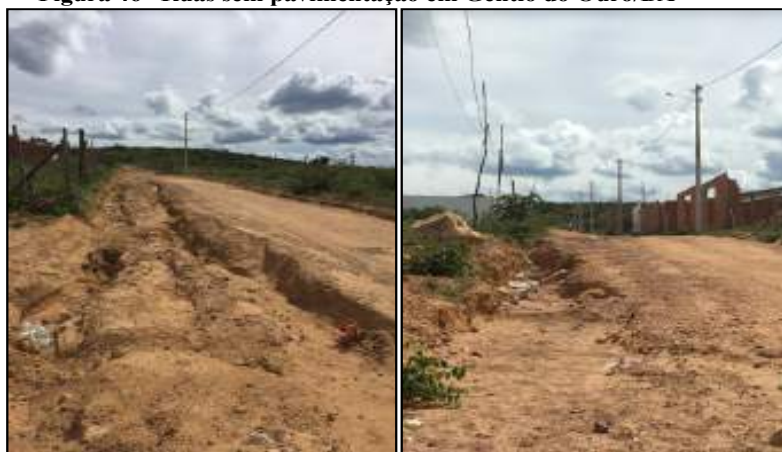
Figura 46– Ruas sem pavimentação em Gentio do Ouro/BA
